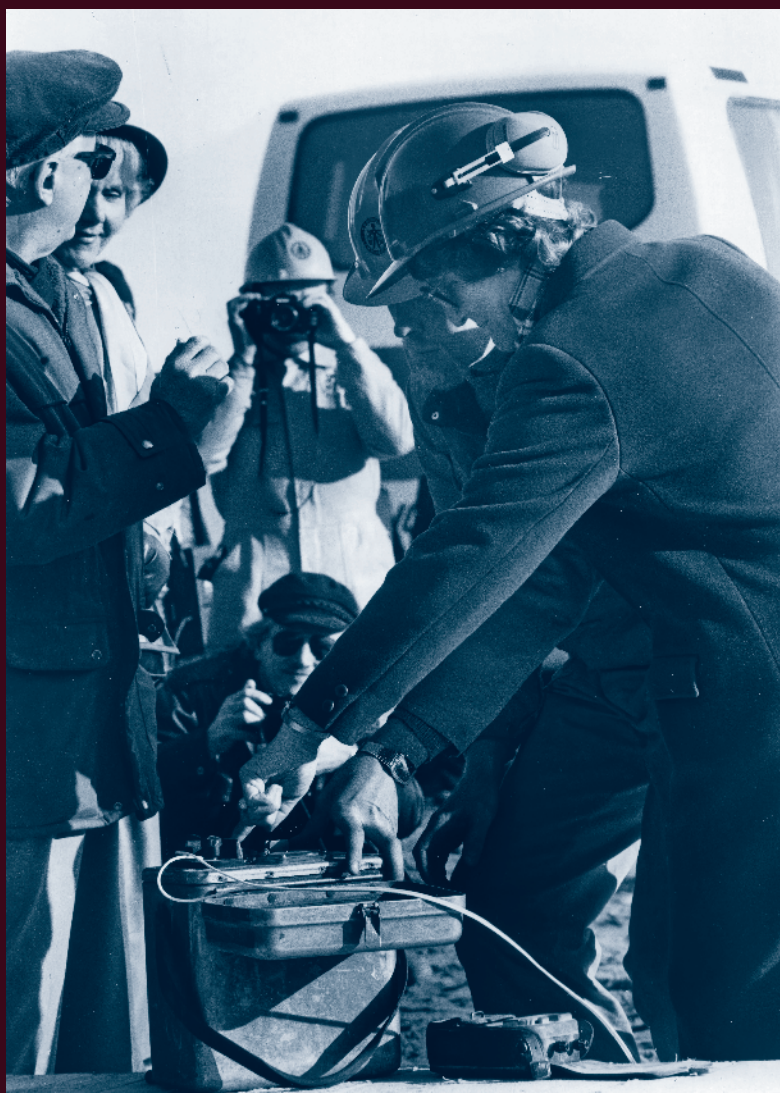
> Maakaasuputken alkupaukku 10.4.1985. Lemminkäisen arkisto.
